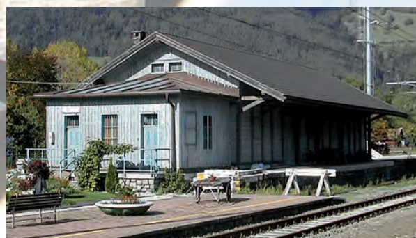
Güterschuppen am Bahnhof Sterzing
