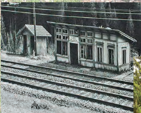
Beim Tunnelbau geschliffene Haltestelle Pflersch
