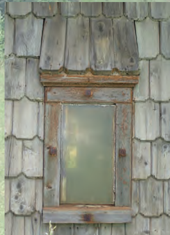
Kunstvoll gestaltete Wand mit überlappenden Schindeln in Biberschwanzform
