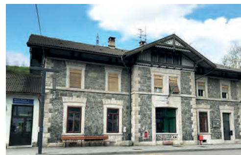
Bahnhof Sterzing, ein Gebäude der IIIa-Klasse mit bahnsteigseitigem Mittelrisalit, ungewöhnlich auch das Bruchsteinmauerwerk.
