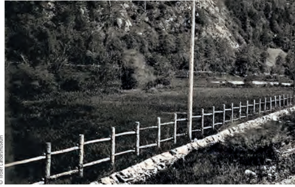
Die Sprengung am Sprechensteinkofel brachte genügend Material für den Dammbau durchs Sterzinger Moos.
