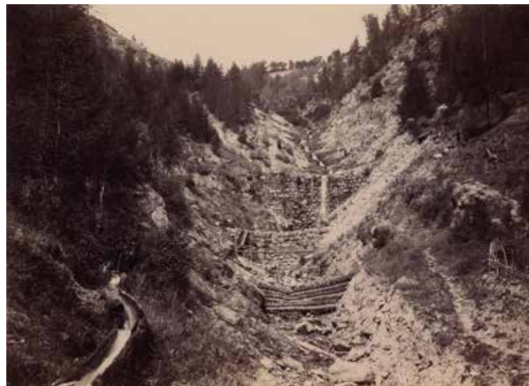
Gemauerte und hölzerne Talsperren am Vallerbach 1876 (Originalfoto von Karl Lindner im Tiroler Landesmuseum Ferdinandeum, Innsbruck)
